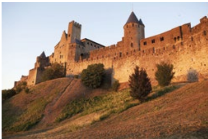
Cité de Carcassonne, front ouest, tour de la Justice et château comtal © Laurent Gueneau / Centre des monuments nationaux
